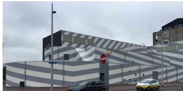
TS-MS station (van 25-66 naar 3-23 kV)
