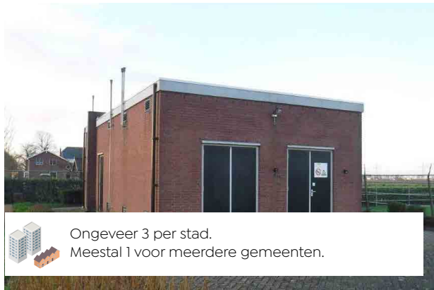
Gasontvangstation (van 50 naar 8 bar)
