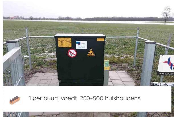
Districtstation / afleverstation (van 1-8 naar <1bar)
