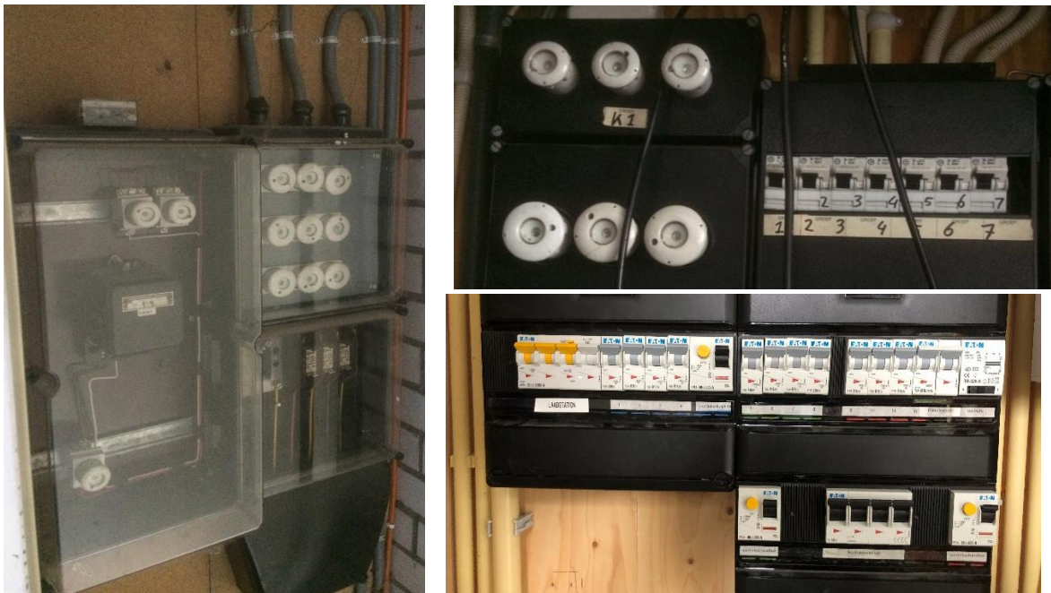
Figuur: links groepenkast met volledig auto stoppen, rechtsboven meterkast met deel nieuwe en deel oude groepen, rechtsonder groepenkast met volledig nieuwe groepen.
